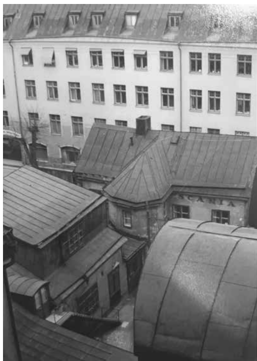
Skandias högkvarter låg på Sveavägen 44. I kvarteret, och hopbyggd med kontorshuset, låg den gamla flickskolan Ateneum för flickor (hörnet Sveavägen / Adolf Fredriks kyrkogata) och på 70-talet fanns ännu en del gammal bebyggelse på andra sidan Kyrkogatan. Utsikten tagen från mitt arbetsrum.
