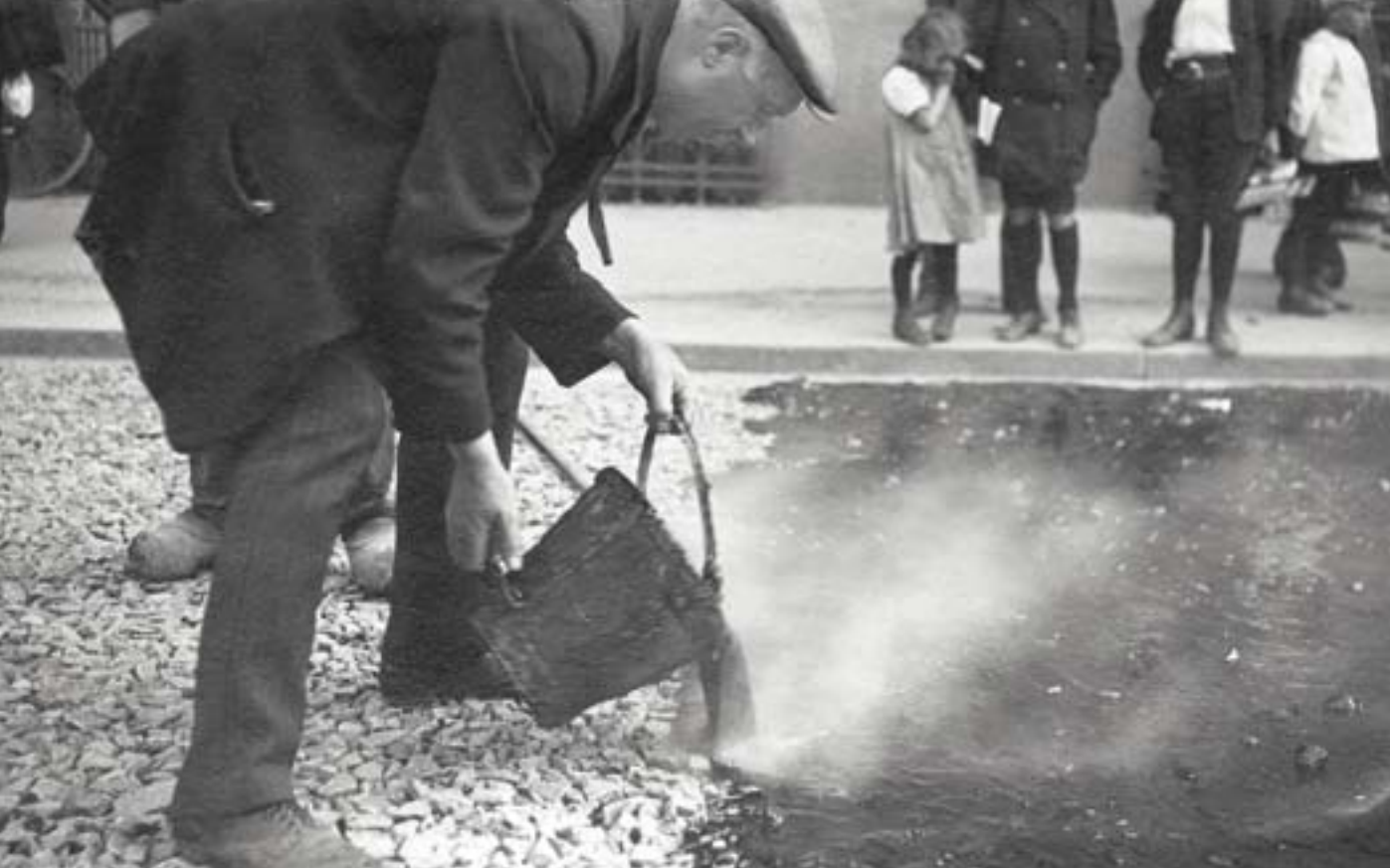
1914: Beläggning av en gata i Malmö med astfaltmakadam enligt genomdräkningsmetoden.
